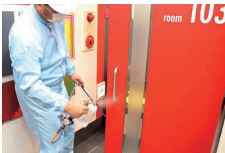
エコキメラ施工の様子
